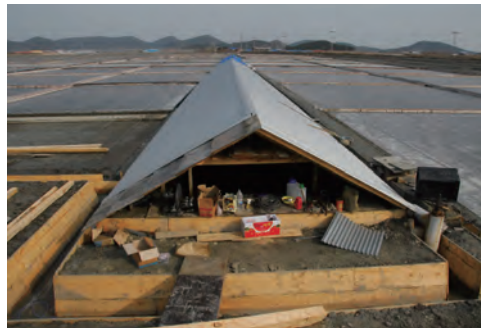
사진2. 슬레이트 지붕을 철거하고 친환경소재로 만든 해주 지붕
