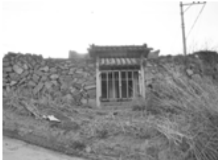
〈사진 1-1〉 팽진리 김희중효자각 전경
